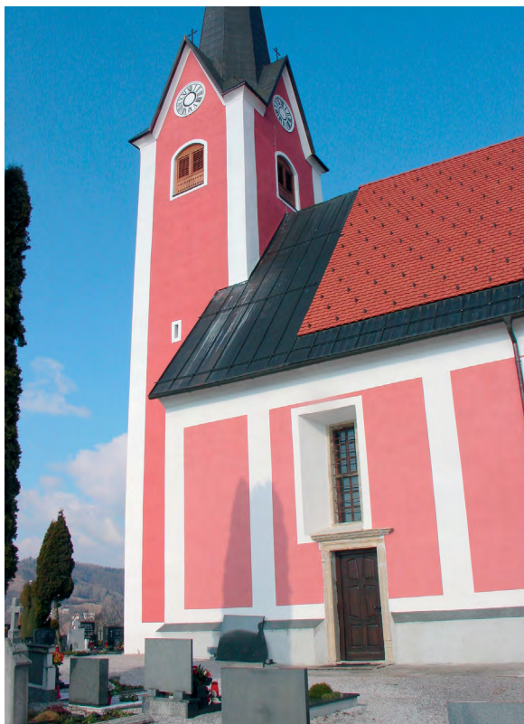
Pogled na del obnovljene zunanjsčine cerkve sv. Križa (foto: A. Plevčak)
