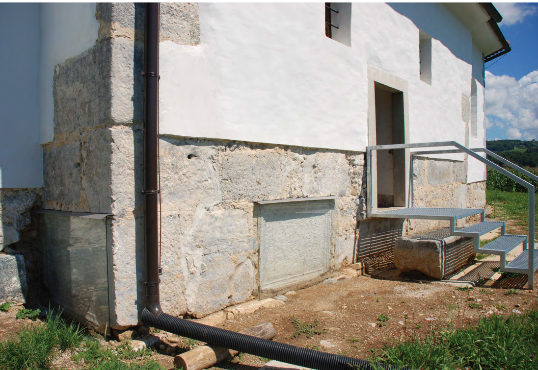
Prezentirana južna fasada cerkve (foto: J. Grobovšek)
