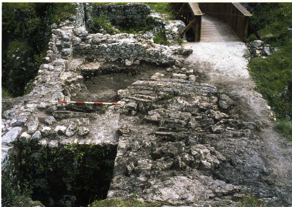
Kozlov rob nad Tolminom, ostanki dvoriščne stavbe. Spredaj ledenica, zadaj prostor ob vhodu z ostanki estriha, v ozadju začasni leseni most prek obrambnega jarka (foto Mitja Guštin).
