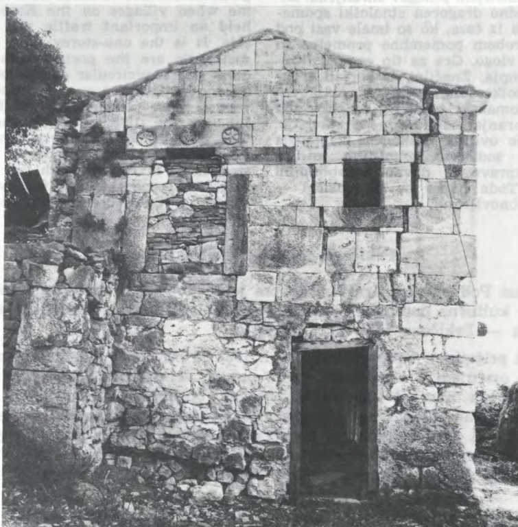
Sl. 63. Podpeč pri Kopru, Prkičeva hiša pred obnovo (f. Jaka Jeraša)
