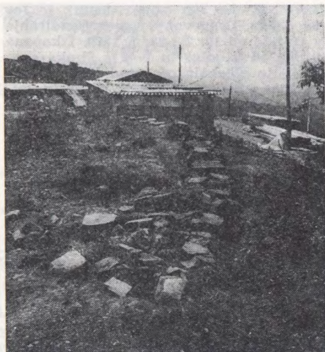
Sl. 110 Gonjače — pogled v izkop
