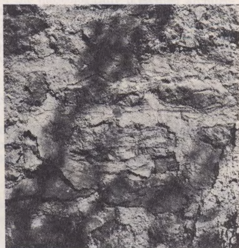
Sl. 7—9 Del južne stene cerkvene ladje z zgodnjeromanskim okencem in štirimi ometi; značilna zidava južne ladijske stene
