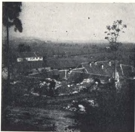
Bistra — izkopavanje temeljev stražnega stolpa. (Foto M. Vidmar)
