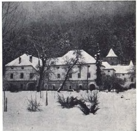
Bistra — pogled na celoto po rekonstrukciji stolpa. (Foto M. Vidmar)
