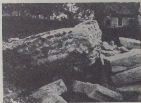
Sl. 1. Odkopani temelj prve grobnice »in situ«
