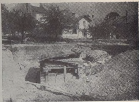
Sl. 4. Isti temelj konec leta 1952
