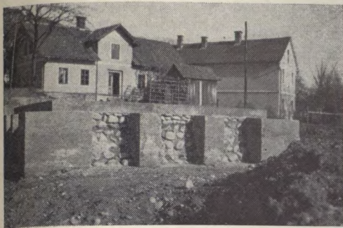
Sl. 5. Rekonstruiran in učvrščen temelj leta 1954
