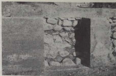
Sl. 6. Južni zabetonirani del temelja do prvega levega stebrička. Vidi se originalni del temelja, ki ga loči od zgornjega dopolnilna vrsta drobcov iz opeke
