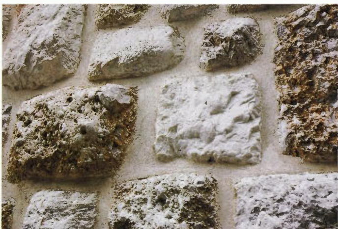
Detajl kamnite fasade.
