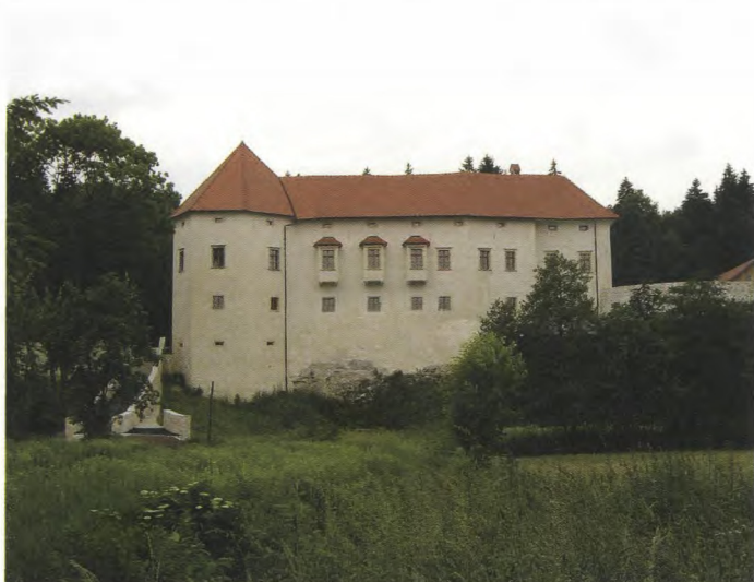
Pogled na vzhodno fasado po obnovi.
